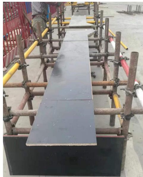
图8 梁底模实景图
