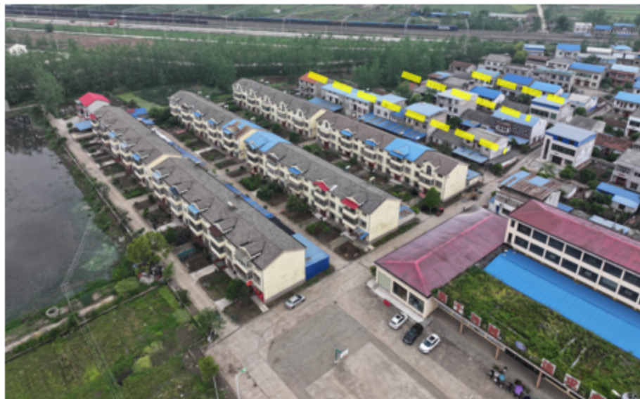
1. 遵循现有的墙排布局 (临江乡耙铺村实拍)
